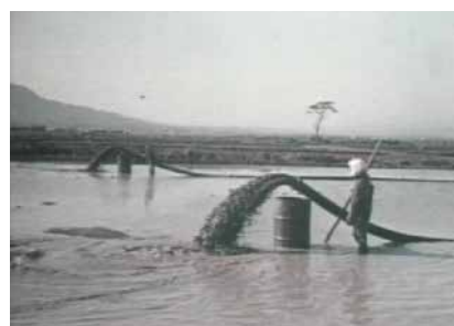
↑ ポンプ排泥客土
