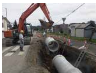
↑ 雨水管の整備 (砂川市)
