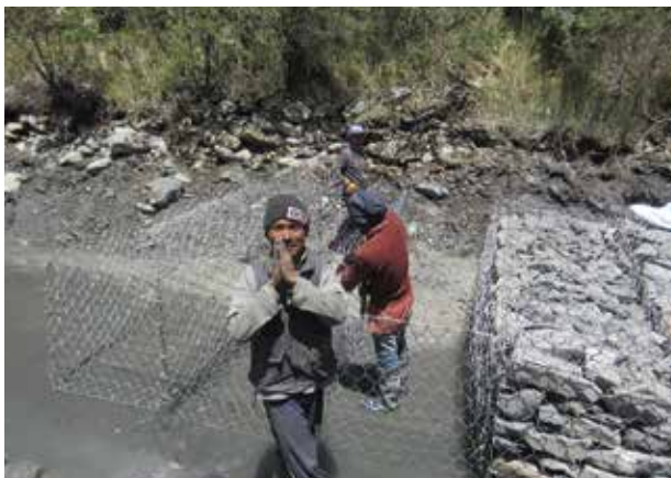
図 11 蛇籠組み立ての作業風景
