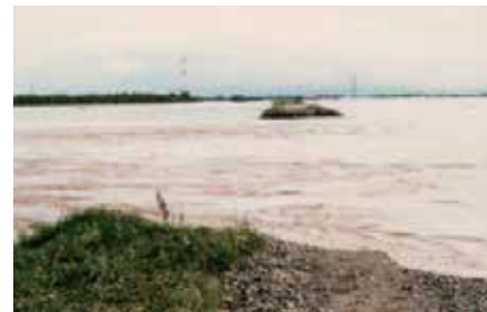
↑同箇所の越水破堤状況
