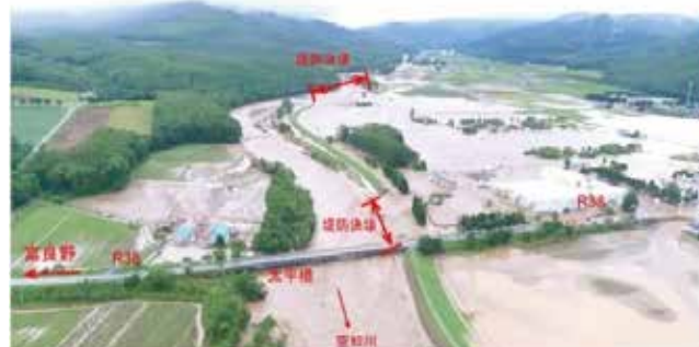
↑空知川（南富良野町）の堤防決壊（平成28年8月）
