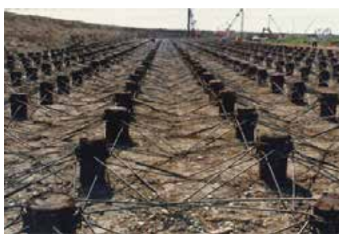
↑ パイルネット工法
