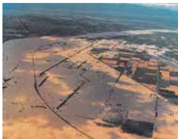
↑昭和56年洪水被災状況（美原地区）
