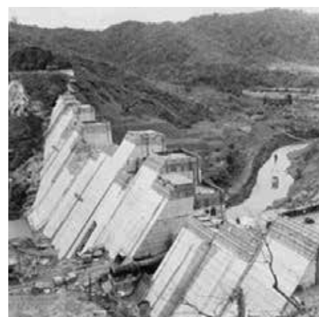
↑ 桂沢ダム建設状況（昭和30年8月撮影）
