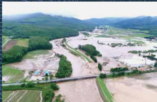
↑空知川左岸堤防の決壊による市街地の浸水 (平成28年8月31日。南富良野町字幾寅)
