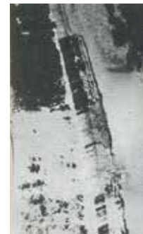
← 昭和 50 年洪水被災状況 （北村築堤の溢水）
