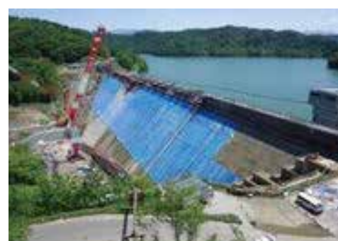
↑嵩上げ工事中新桂沢ダム（令和元年撮影）
