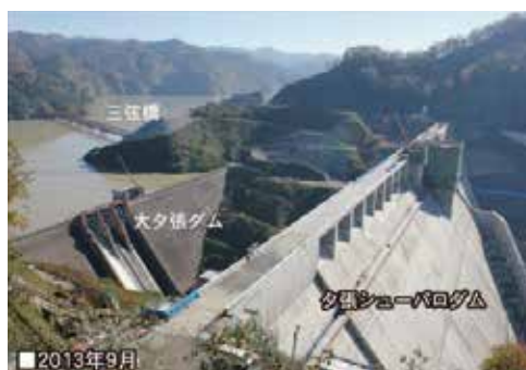
↑建設中の夕張シューパロダム（平成25年撮影）
