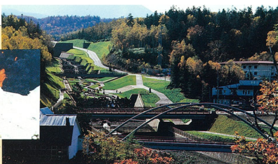
上川郡美瑛町白金温泉十勝岳流路工 冬季に十勝岳が噴火した場合の危機管理として、火山泥流の直撃を受ける白金温泉を守るため、昭和63年噴火後、災害関連緊急事業によって、観光地に相応しい景観も考えた泥流を導く流路工の施工を行った。
