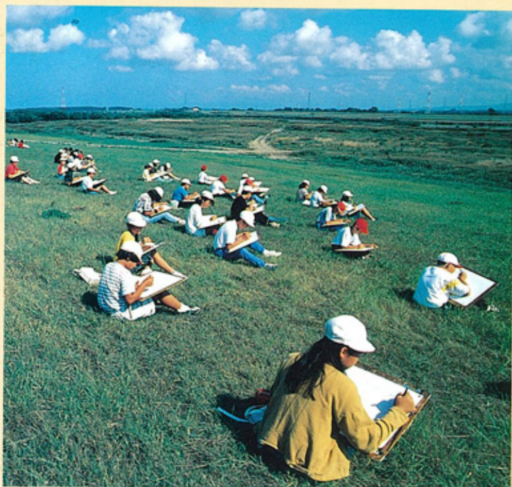
丘陵堤 石狩川の堤防を緩い傾斜にして大きくする事業。堤防の強化が目的ですが、するとゆったりとした緑の丘が出来あがります。
