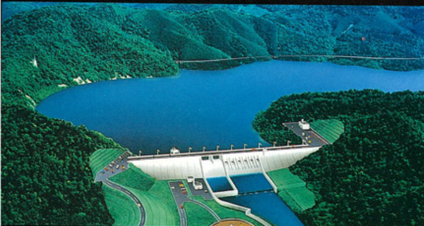
空知川・石狩川流域の治水と水道、発電、かんがいを担う多目的ダム。
